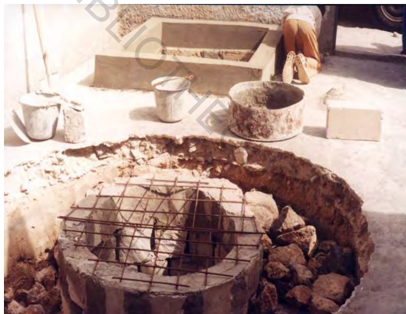
Photo n° 9 : ouvrage d'assainissement (bac à laver-puisard)
