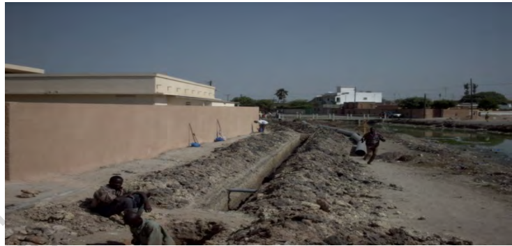
Photo n° 11 : installation de réseau d'évacuation des eaux usées
