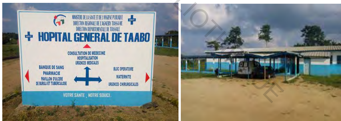
Figure 5 : Photo montrant le bâtiment principal de l'hôpital général de Taabo
